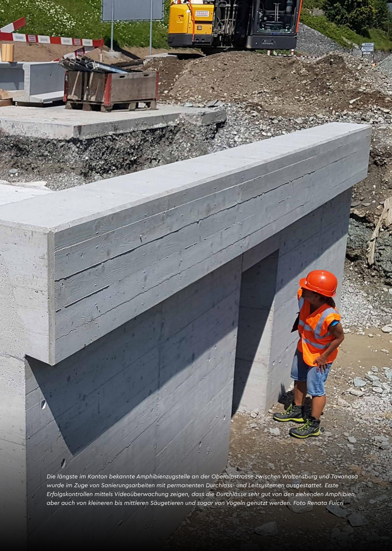
*Die längste im Kanton bekannte Amphibienzugstelle an der Oberalpstrasse zwischen Waltensburg und Tavanasa wurde im Zuge von Sanierungsarbeiten mit permanenten Durchlass- und Leitsystemen ausgestattet. Erste Erfolgskontrollen mittels Videoüberwachung zeigen, dass die Durchlässe sehr gut von den ziehenden Amphibien, aber auch von kleineren bis mittleren Säugetieren und sogar von Vögeln genutzt werden. Foto Renata Fulcri*
